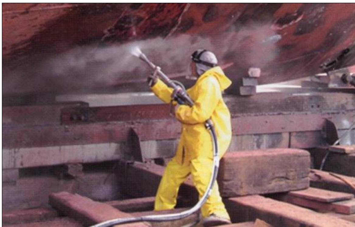
Figura 63. Trabalho de decapagem por água – (Fonte. McQuilling Partners, Inc.).
