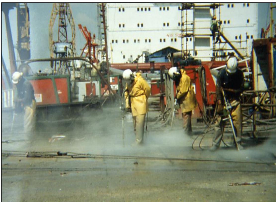
Figura 64. Jateamento do convés por hydroblasting – (Fonte. McQuilling Partners, Inc.).
