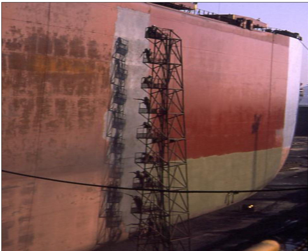
Figura 46. Jateamento do casco do navio em doca com abrasivo sólido – (Fonte. McQuilling Partners, Inc.).
