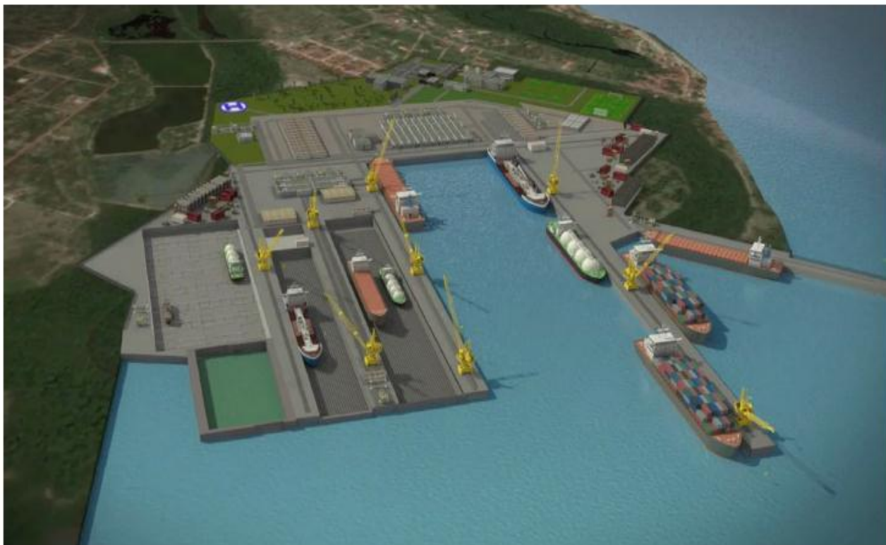
Figura 31. Vista aérea frontal da área industrial do estaleiro EDPI, destacando os diques, hydrolift, cais e piers. – (Fonte. McQuilling Partners, Inc.).
