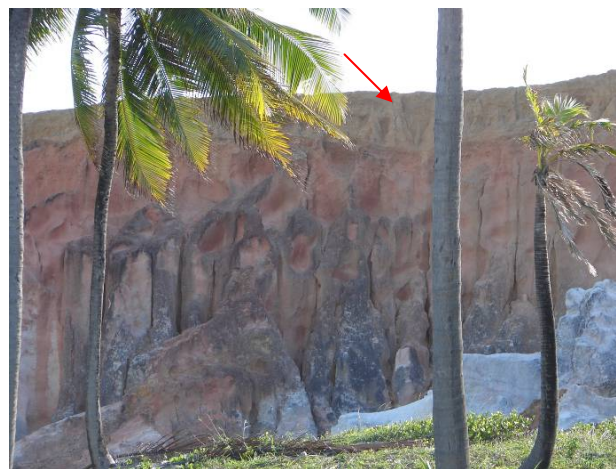
Foto 4.2 – Vista da encosta mostrando a sequência sedimentar da unidade geológica Barreiras encontrada na AID
