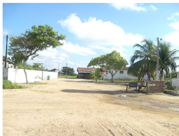
Foto 4.20 – Via de acesso ao Assentamento Tambaba, estruturada em revestimento primário
